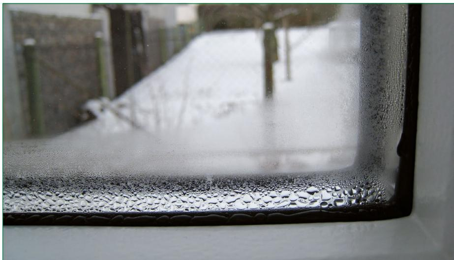
Fig. 3 : de légères traces d'eau de condensation peuvent se former au bord de la vitre en raison de l'intercalaire en aluminium à l'intérieur du vitrage isolant.
