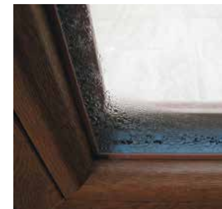
Bei extremen minus 28 Grad Celsius Außentemperatur sind selbst bei Dreifach-Isolierglas mit Warmer Kante physikalische Grenzen überschritten.
